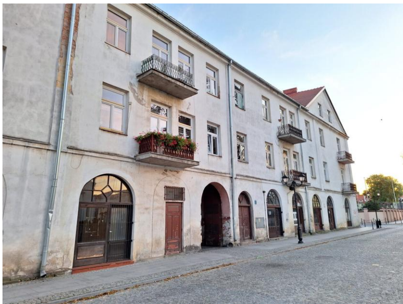
Fotografia 21. Opuszczone lokale usługowe przy ul. Benedyktynskiej
