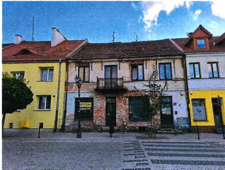
Fotografia 17. Jedna z zaniedbanych kamienic przy Rynku
