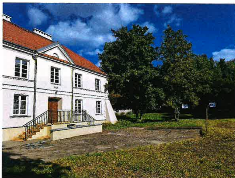
Fotografia 12. Zaplecze siedziby Pułtuskiej Biblioteki Publicznej im. Joachima Lelewela
